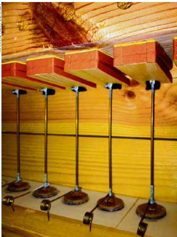
Palkeet ja venttiilit ovat piilossa urkujen sisällä ilmalaatikoissa.
